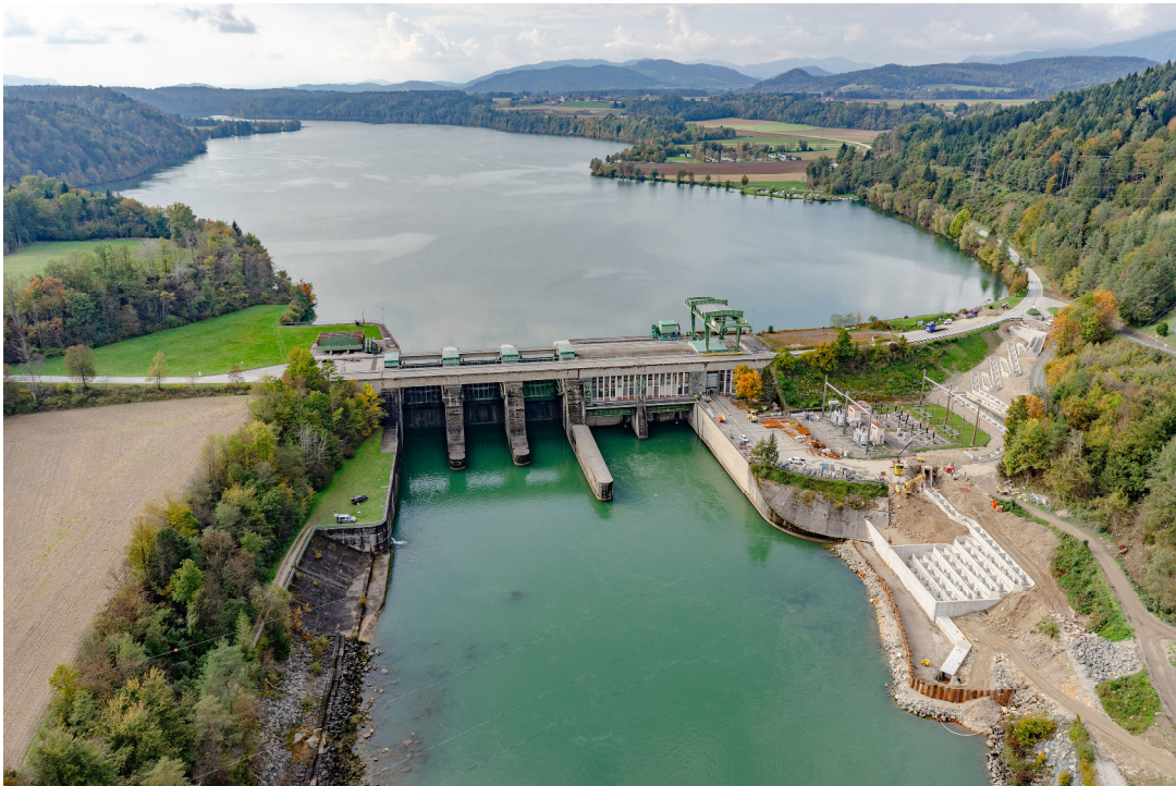
Abb. 4: Errichtung der FAH KW Edling (Foto: Verbund AG)
